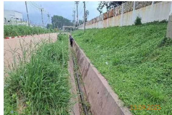
รูปที่ 2-11 การขุดลอกตะกอนในรางระบายน้ำฝน
